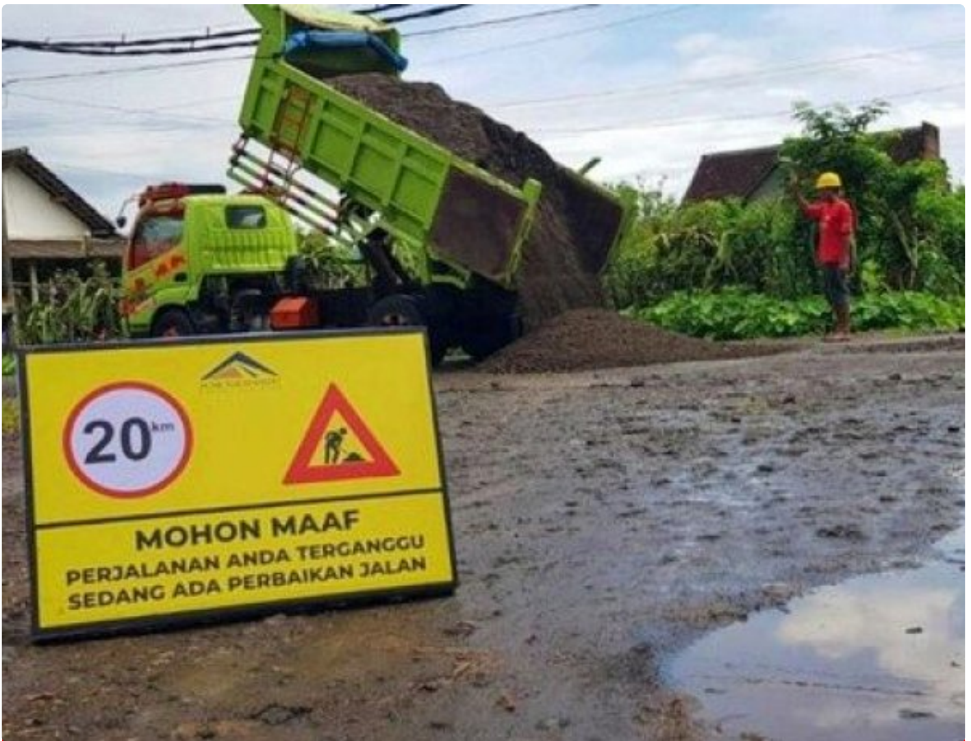
Perbaiki jalan rusak di Banyuwangi
