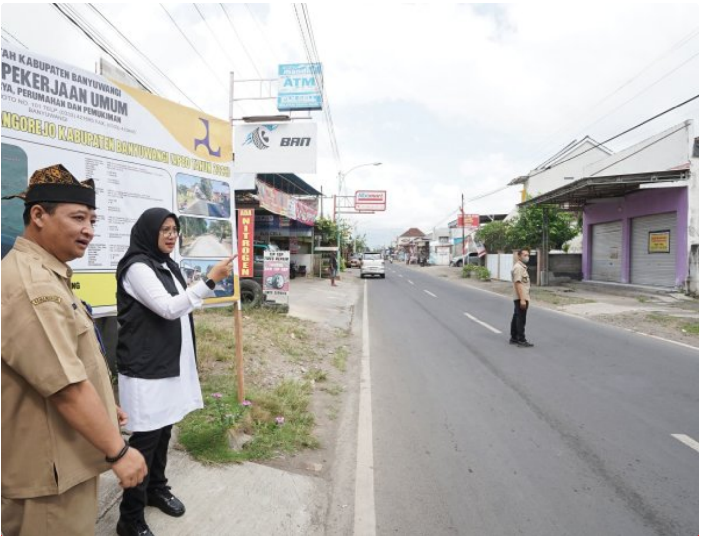
Bupati Banyuwangi Ipuk Fiestiandani melakukan pengecekan progres pembangunan jalan saat ngantor di tiga desa Kecamatan Bangorejo, Selasa (10/9/2024).
